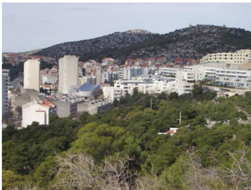
Pogled s Kamenara: Gradski kvart Šubićevac
