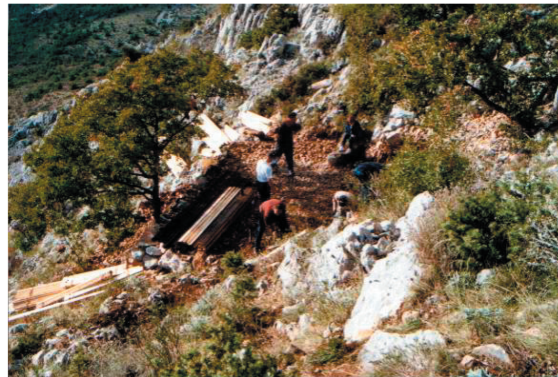
▲ Radovi na temeljima spavaonice
